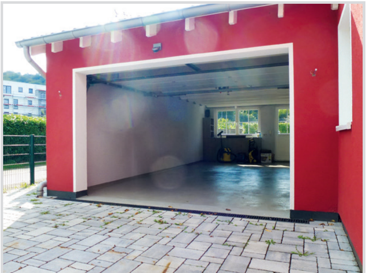
Übergroße Garage mit Stauraum im Spitzboden, Wasseranschluss und Heizung
