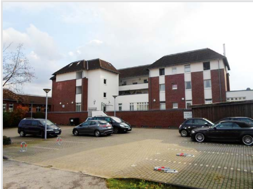
Gebäuderückseite mit Zugang zu den Wohnungen
