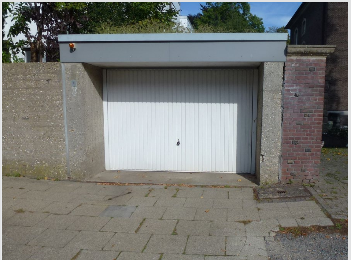
Zufahrt elektrifizierte Tiefgarage
